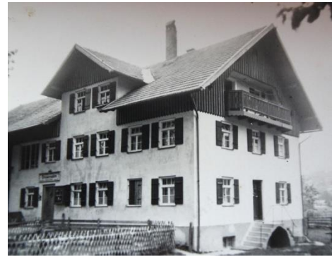
Umbau und Renovierung
